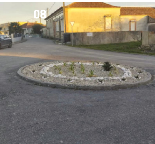
08. Requalificação do espaço público, Carregal
