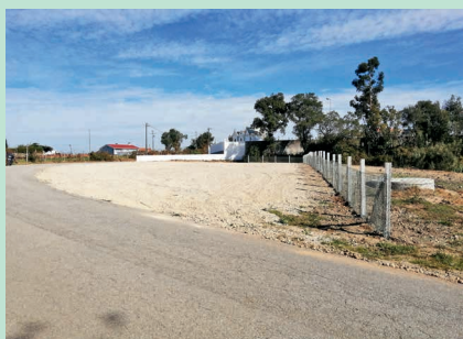
1ª fase do estacionamento do Cemitério do Viso – Nª Srª Fátima
