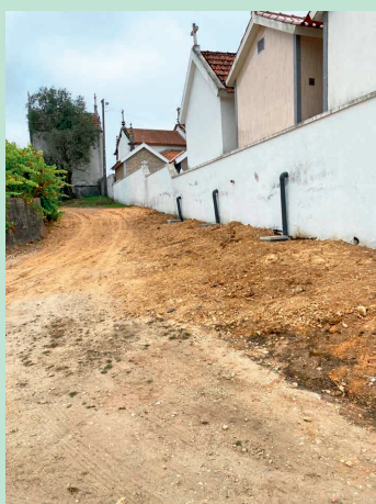
Tratamento de águas pluviais Cemitério de S. Paio Requeixo
