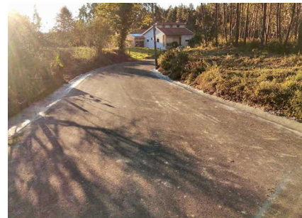
Valetas na Rua da Fonte do Olho Nariz
