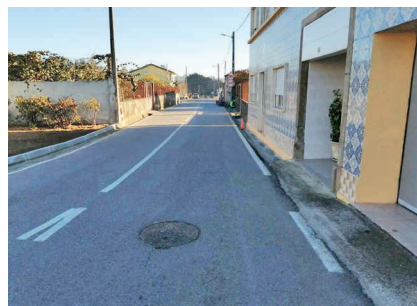
Valetas na Rua Direita – Verba
