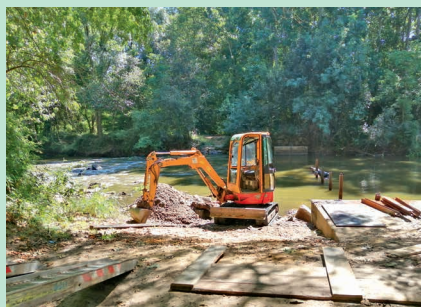
Travamento da água do rio – Requeixo
