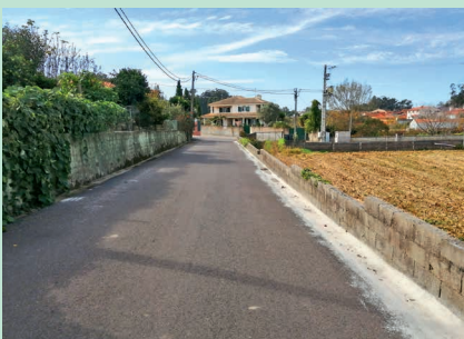
Valetas na Rua do Paraíso Rua e Travessa do Rochio – Requeixo
